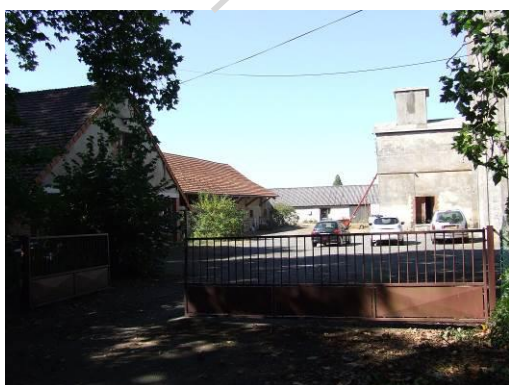
Vue sur le site depuis la RD21
